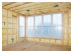
天井・壁等の断熱改修工事
