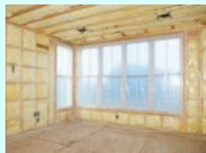
天井・壁等の断熱改修工事
